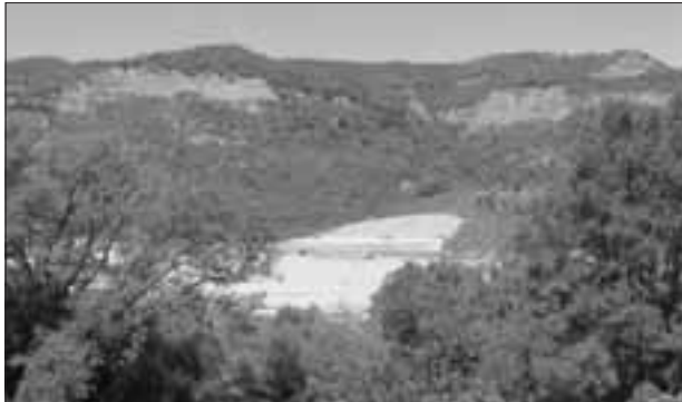
Lo stato dei luoghi dopo lo sbancamento
